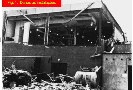
Fig. 1: Danos às instalações
